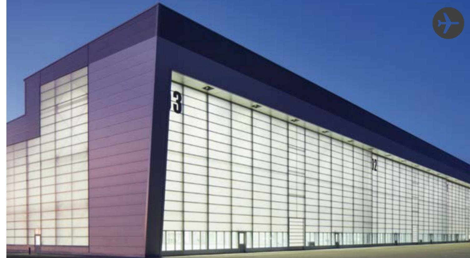
Tor- und Fassadenelemente aus lichtdurchlässigem Fiberglas erzeugen besonders bei Nacht eine interessante Optik.
