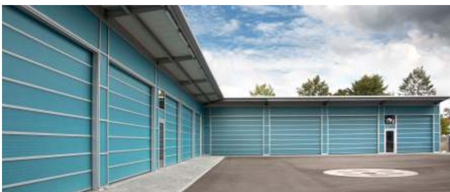
Stadtwerke Traunreut (DE) - VARIOPLANplus Fassade kombiniert mit Butzbach Toren
